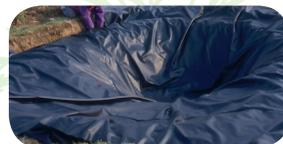
Disposez un feutre de protection et une bâche EPDM sur le sol de la future mare et de la tranchée, en épousant au mieux la forme du trou et en évitant les plis.
