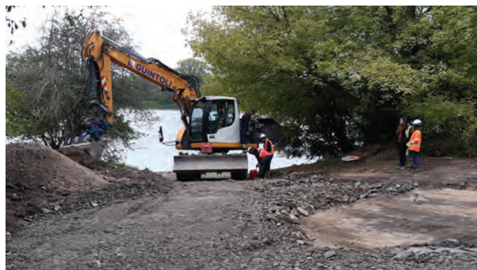
Travaux de restauration d'une cale de mise à l'eau à La Chapelle-Saint-Mesmin © D. Hémeray
