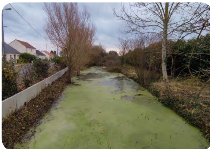
Fin du chantier d'Amilly où les berges ont été dégagées et une partie des herbes dans l'eau a été retirée © N. Déjean
