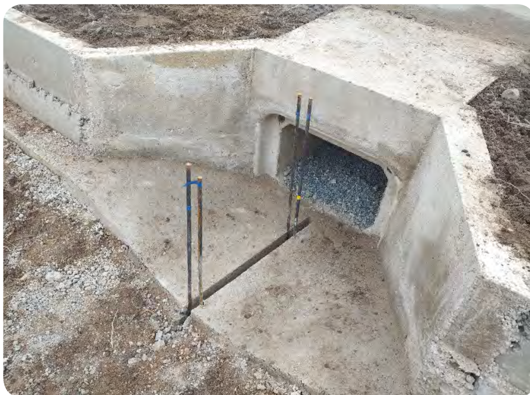
Entrée d'un passage à petite faune © K. Billard
