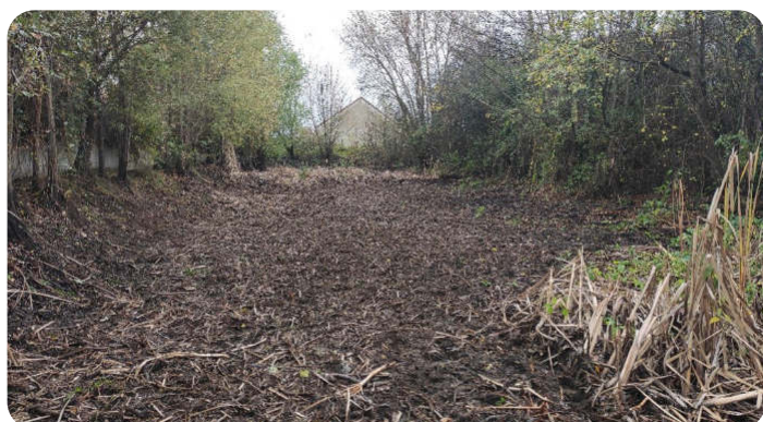
Fin chantier mare-Amilly © N.Déjean
