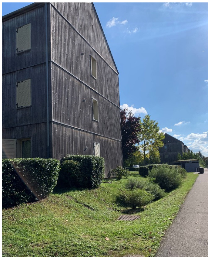
Noue pour gérer par infiltration l'eau pluviale d'une résidence LOGEM © LNE
