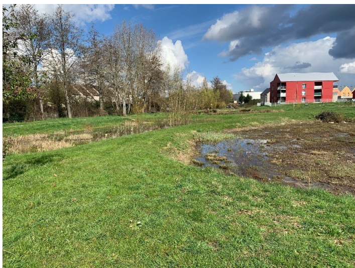
Mare et bassins tampon pour gérer l'eau pluviale dans la zone inondable de l'écoquartier des Rives du Solin © LNE
