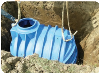
Il est préférable de prévoir l'installation d'une citerne enterrée avant l'implantation du jardin car cela entraîne des travaux importants.
