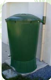
Récupérateur d'eau équipé
