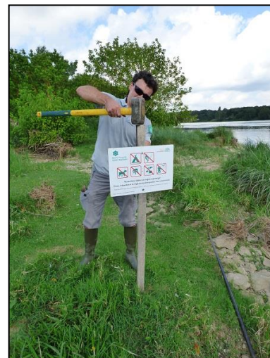
Installation d'un panneau réglementaire sur une île à Mareau
