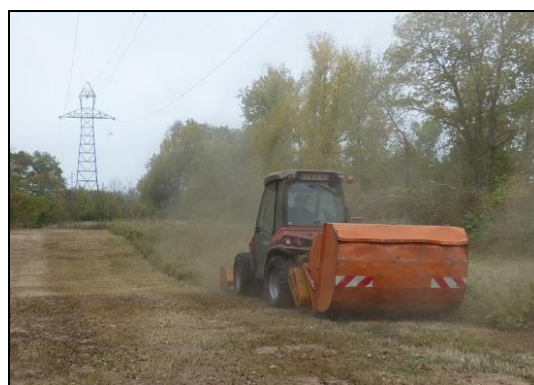
Broyage de la végétation sous les lignes haute-tension à la Pointe de Courpain
