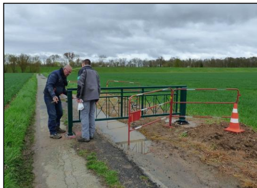
Travaux d'installation d'une barrière à Mareau-aux-Prés
