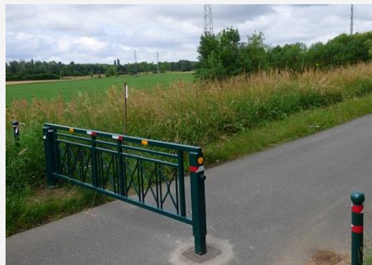
Barrière sur la levée à Mareau-aux-Prés pour limiter la fréquentation aux abords de la Pointe de Courpain
