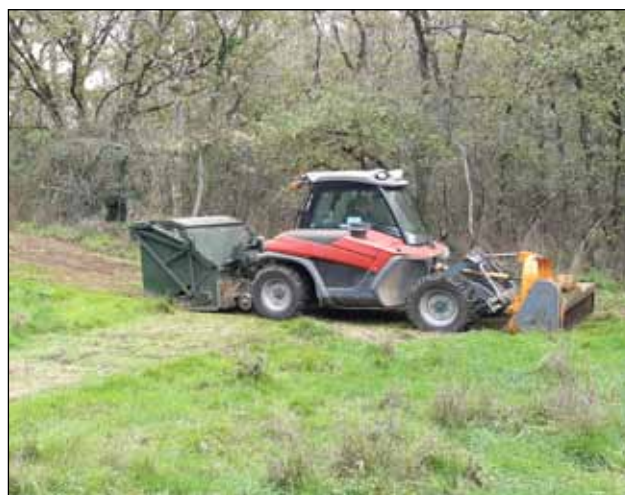
Broyage de la végétation sous les lignes de la Pointe de Courpain
