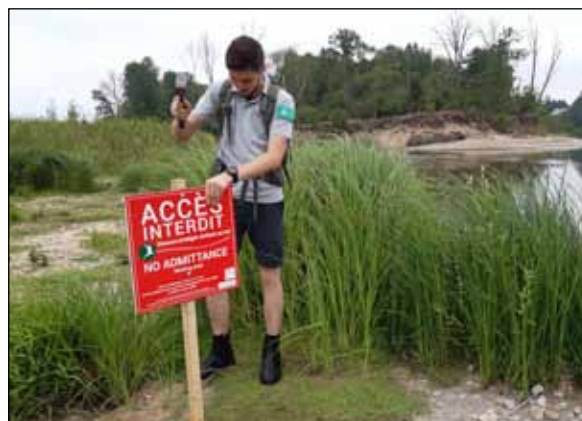
Installation de panneaux APB sur les îles de Mareau
