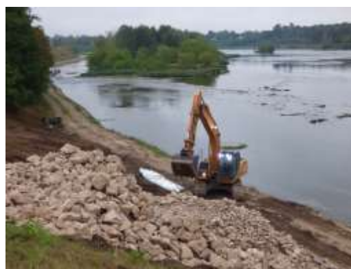
Dernière phase du chantier de renforcement de la levée à Mareau-aux-Prés
