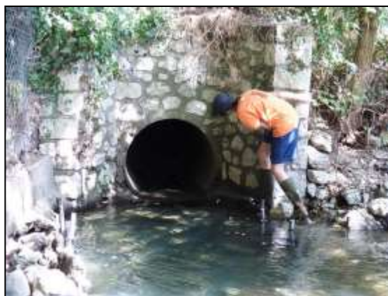
Inspection d'un exutoire. L'origine de l'eau rejetée sera à rechercher
