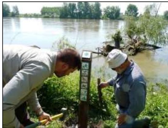
Réparation d'une borne
