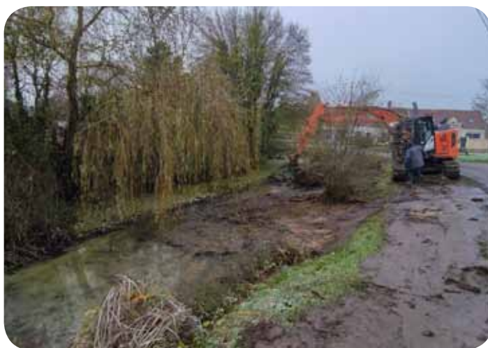
Curage mécanique d'une mare de Griselles © N. Déjean
