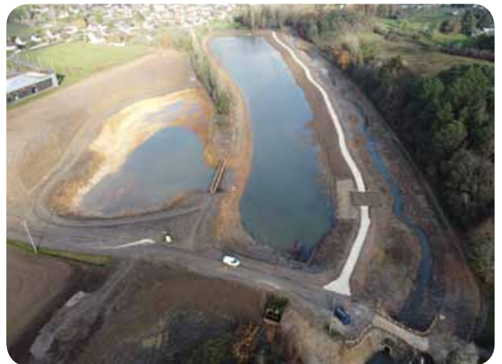
PTGE - réaménagement des étangs de Nogent-sur-Vernisson et restauration du cours du Vernisson © J.L Charleux
