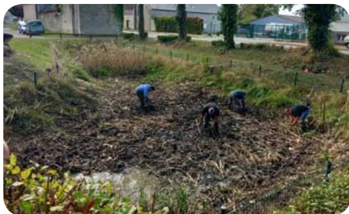
Chantier de la mare de Denainvilliers : arrachage des massettes © A. Fèvre
