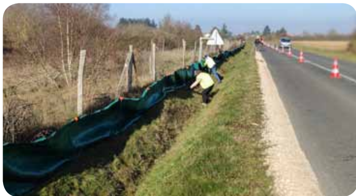
Chantier barrière-piège © N. Déjean
