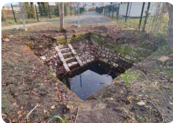
Mare de Saint-Jean-de-la-Ruelle après travaux © N. Déjean
