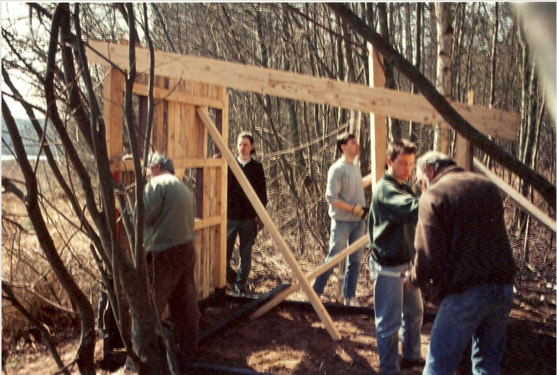
1993 construction du 1er affût pour l'observation du balbuzard près de l'étang du Ravoir A.Berger, A. Hergibo, R. Hardouin, J.C. Vignane, S. Branchereau
