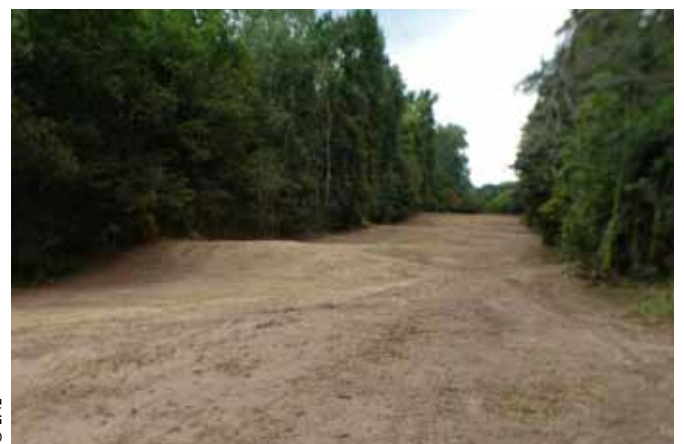
Végétation sous la ligne de la Pointe de Courpain, après travaux
