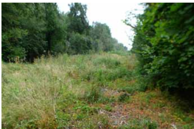
Végétation sous la ligne de la Pointe de Courpain, avant travaux
