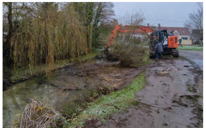
Curage mécanique d'une mare de Griselles © N. Déjean
