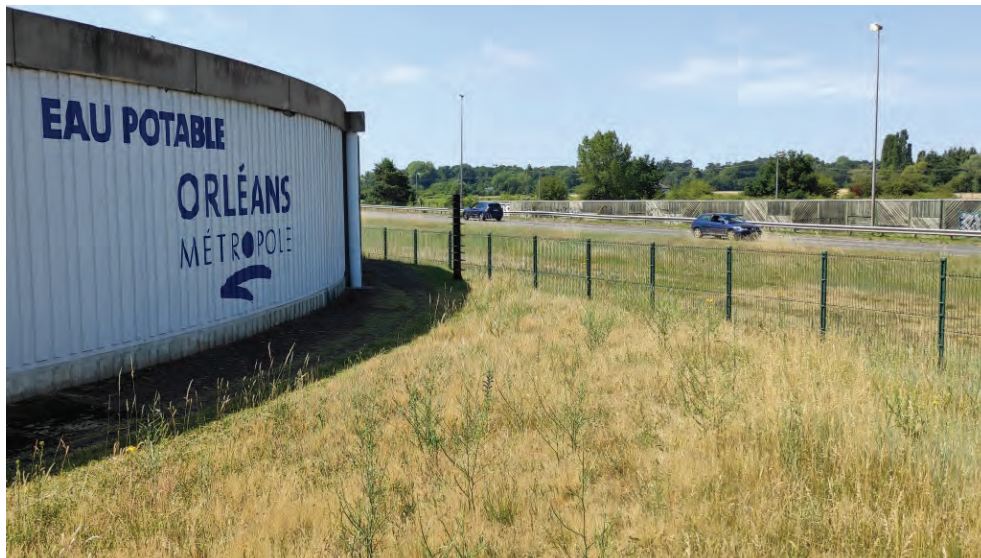
Usine du Val et secteur en gestion différenciée © N. Déjean
