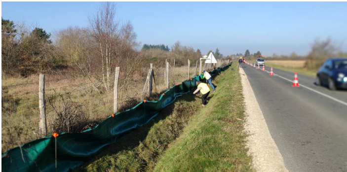
Chantier barrière-piège © N. Déjean
