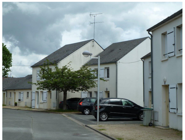
Neuville-aux-Bois : ensemble de logements sociaux. La présence/absence d'oiseaux et de chauves-souris a été vérifiée ce printemps, en amont du chantier qui aura lieu en 2024 © LNE
