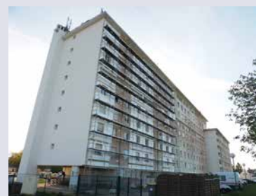
▲ Immeuble avant rénovation
