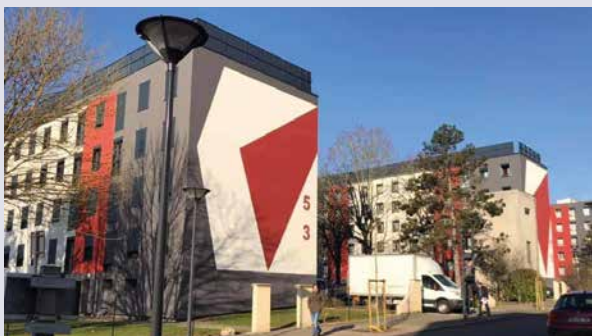
▲ Immeubles après rénovation
